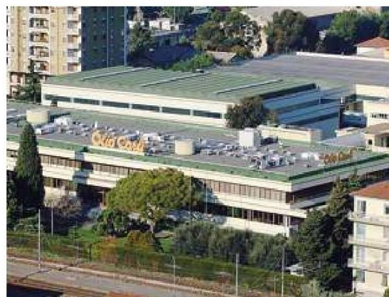
Lo stabilimento imperiese della "Olio Carli", un marchio consolidato
